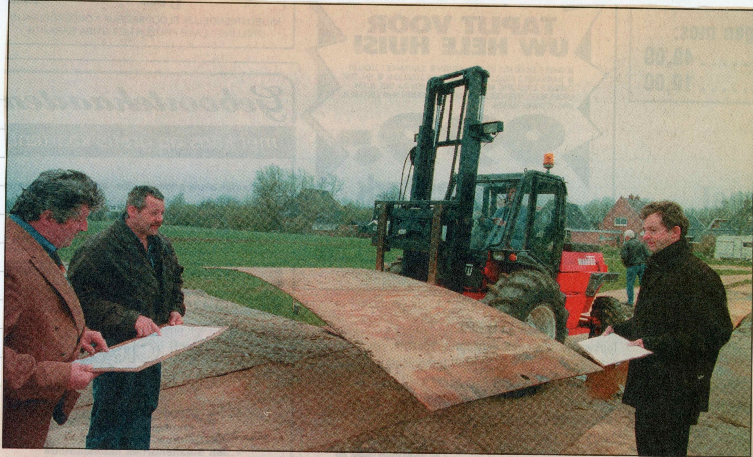
Het Expo-bestuur bekijkt het bouwschema van de drie beurshallen, waarmee gisteren een begin is gemaakt. Een van de hallen wordt honderd meter, en is daarmee de langste die ooit in het Noorden heeft gestaan. Het beursoppervlak telt maar liefst 3500 vierkante meter. Expo99 is daarmee de grootste beurs ooit. Vanaf volgende week woensdag presenteren tachtig standhouders zich voor U op de laatste regiobeurs van deze eeuw. Zoiets moet je gezien hebben! (foto: Alex Bouma)
